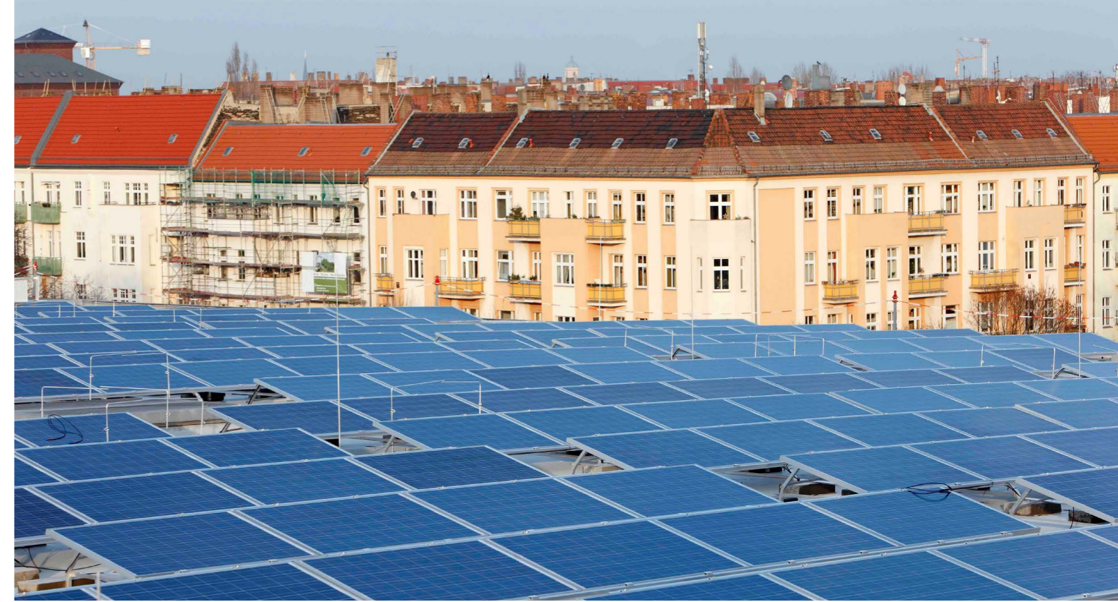
Abb. 14: Solaranlage auf der Max-Schmeling-Halle in Berlin Prenzlauer Berg (Foto: Berliner Energieagentur GmbH)
