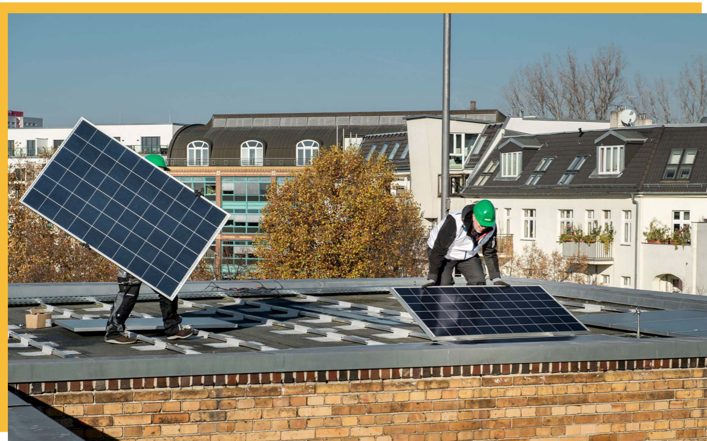
Abb. 15: Installation von Solaranlagen auf der Max-Taut-Schule (Foto: Berliner Stadtwerke GmbH | Benjamin Pritzkeleit)
