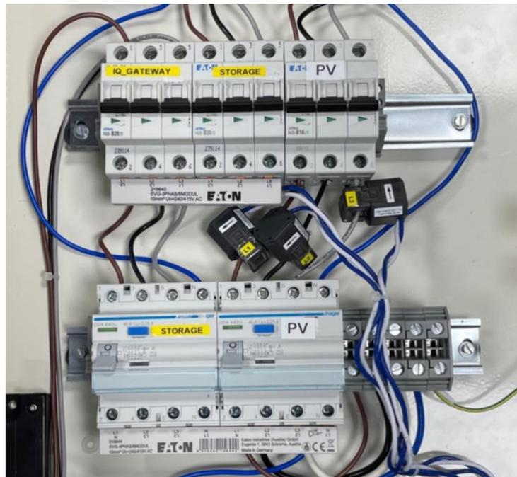
3. Nachdem alle Stromwandler an den Kabeln installiert wurden, befolgen Sie die nachstehenden Schritte, um die Verkabelung zum IQ Gateway abzuschließen
