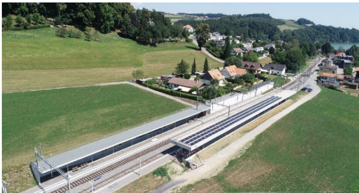
Abbildung 10: Perrondach Haltestelle Pensier (Bild: © TPF mit Genehmigung von Swiss Solar City)
