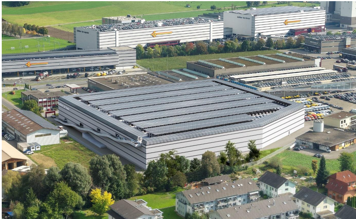
Abbildung 9: 2.1 MWp Parkplatzüberdachung bei der Firma Galliker Transport & Logistics in Altishofen (Bild: © Galliker Transport)
