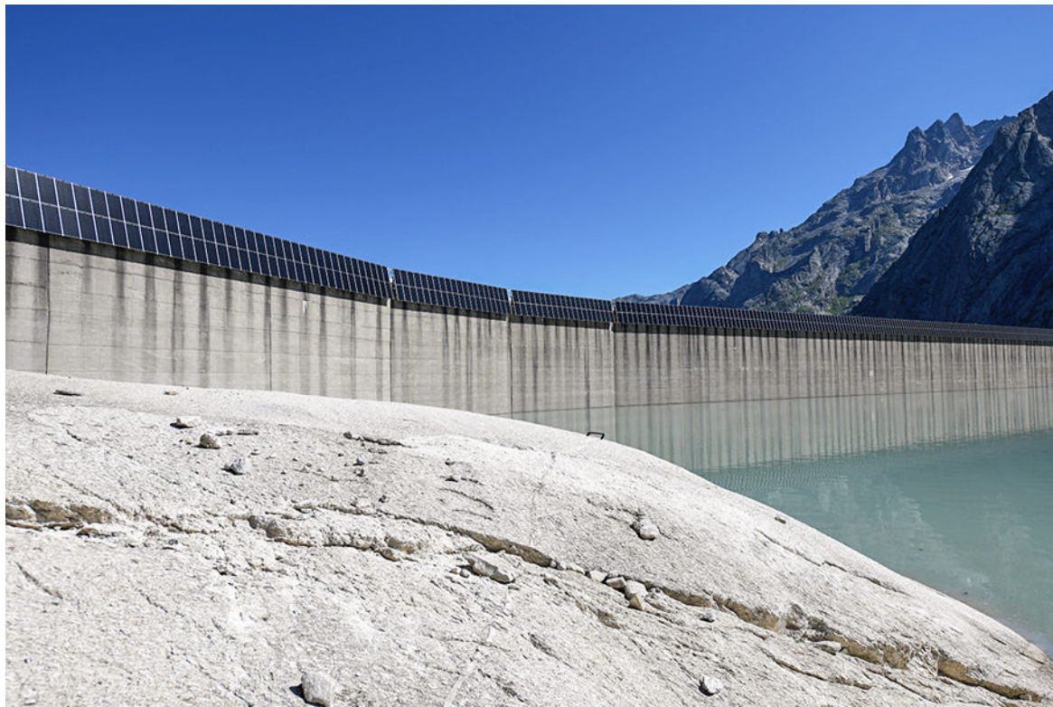
Abbildung 12: Im Bergell hat die ewz die erste PV-Anlage der Schweiz an einer Staumauer verwirklicht (Bild: © ewz).
