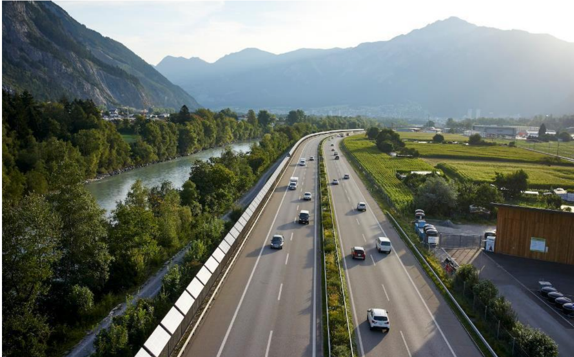
Abbildung 1: Die älteste Solaranlage auf einer Lärmschutzwand von 828 Meter an der A13 bei Chur (Bild: © TNC)
