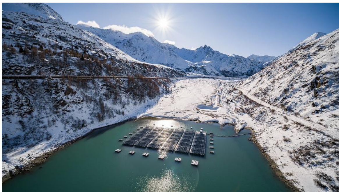
Abbildung 14: Auf dem Lac de Toules wurde die erste schwimmende PV-Anlage der Schweiz errichtet (Bild: Romande Energie).
