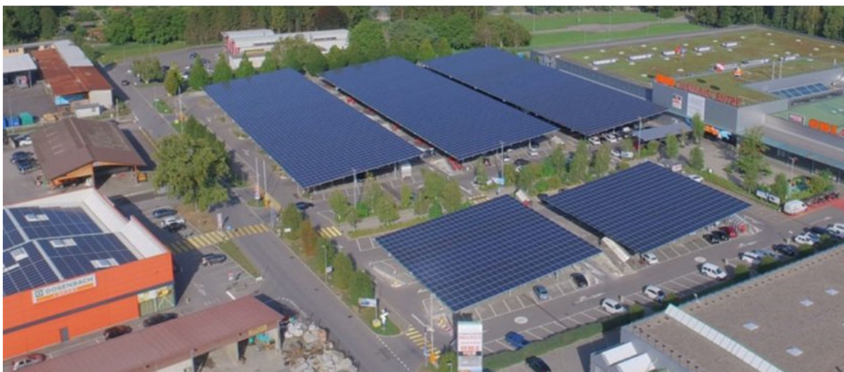
Abbildung 8: Mit dem «Solarparkplatz» deckt die Migros im Einkaufszentrum Chablais in Aigle rund die Hälfte ihres Stromverbrauchs. Die Eigenverbrauchsquote liegt bei 70% (Bild: © Romande Energie).
