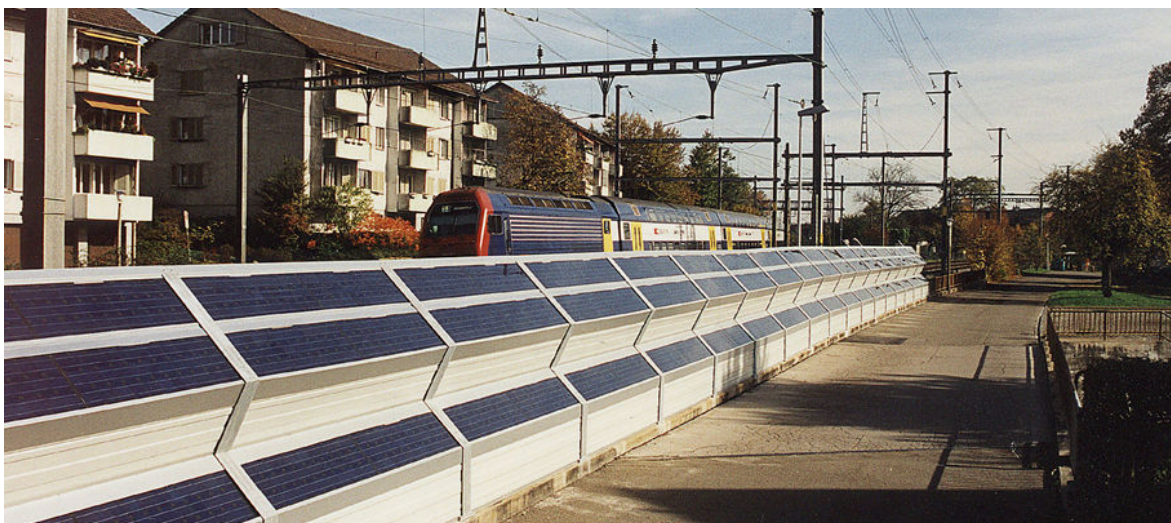
Abbildung 2: Schon 1997 wurde die weltweit erste integrierte PV Schallschutzanlage entlang der Bahn in Wallisellen gebaut (Bild: © TNC)
