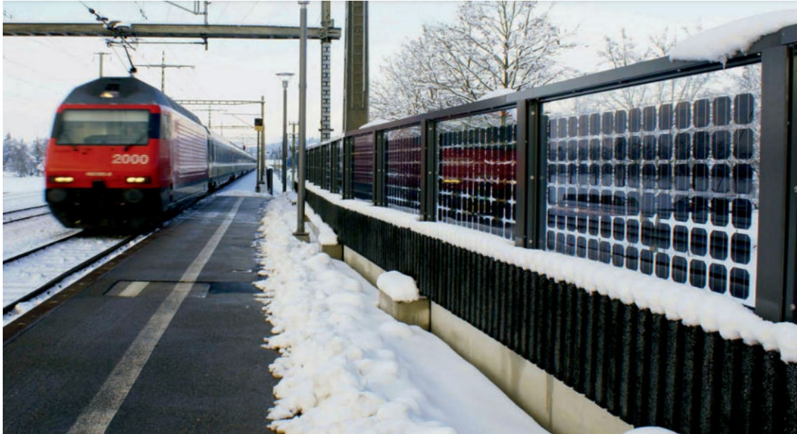
Abbildung 3: Bifaziale Module bei der integrierten PV-Anlage in der Lärmschutzwand in Münsingen (Bild: © TNC)
