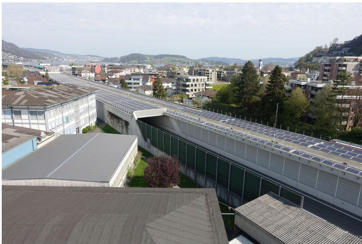
Abbildung 6: Autobahngalerie in Stansstad mit PV-Anlage (Bild: © Alpnach Sonnenstrom AG)
