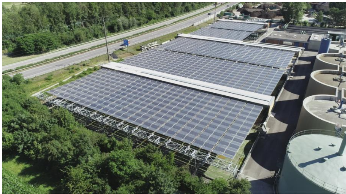
Abbildung 15: In der ARA Chur wurden die Klärbecken mit einer einfahrbaren Falt-PV-Anlage überdeckt (Bild: © dhp).
