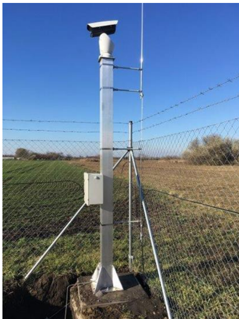
Mast mit Schwenk-/Neigekamera und Blitzfangstange
